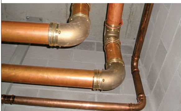
Tubi e gomiti in rame di diversi diametri.
